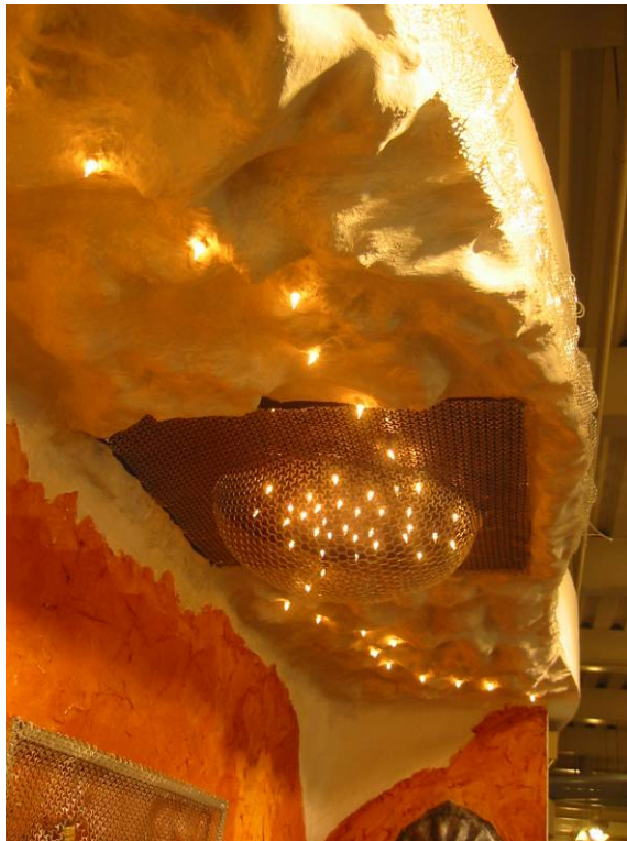
Licht-Deckengestaltung aus FORMETAL VARIUS und FORMETAL Verbundsystem FLEXORIT kombiniert mit Halbkugel aus sichtbarem FORMETAL YPSILON.
