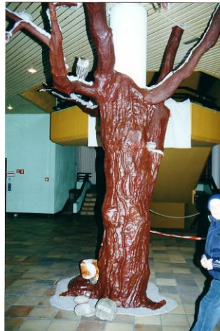
FORMETAL Verbundsystem FLEXORIT : Verkleidung einer Betonsäule des Schwimmbades „SEZ“ Berlin, Landsberger Allee. Material: FORMETAL VARIUS , Quadrofaser, FORMETAL FLEXORIT Idee, Projektierung, Ausführung: Iona Maennchen, Berlin
