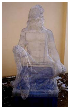
Die fertige Metallform aus FORMETAL VARIUS nach dem Zusammenbau.
